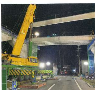
道路改良工事
